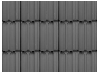
TILE ROOF 'Existing'
