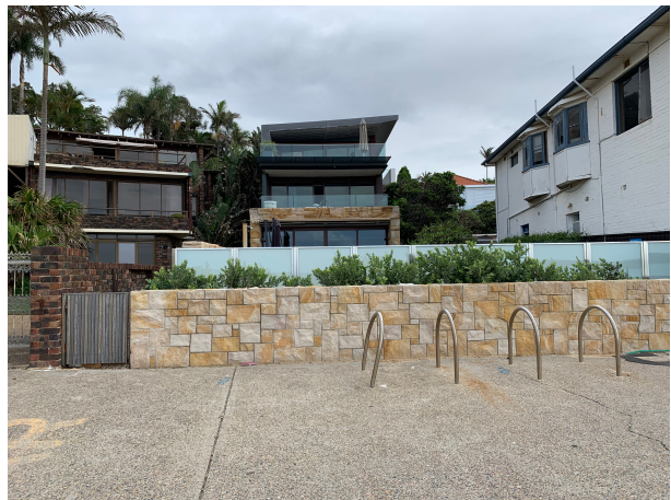
(d) Adjoining property to the west (92 Bower Street)
