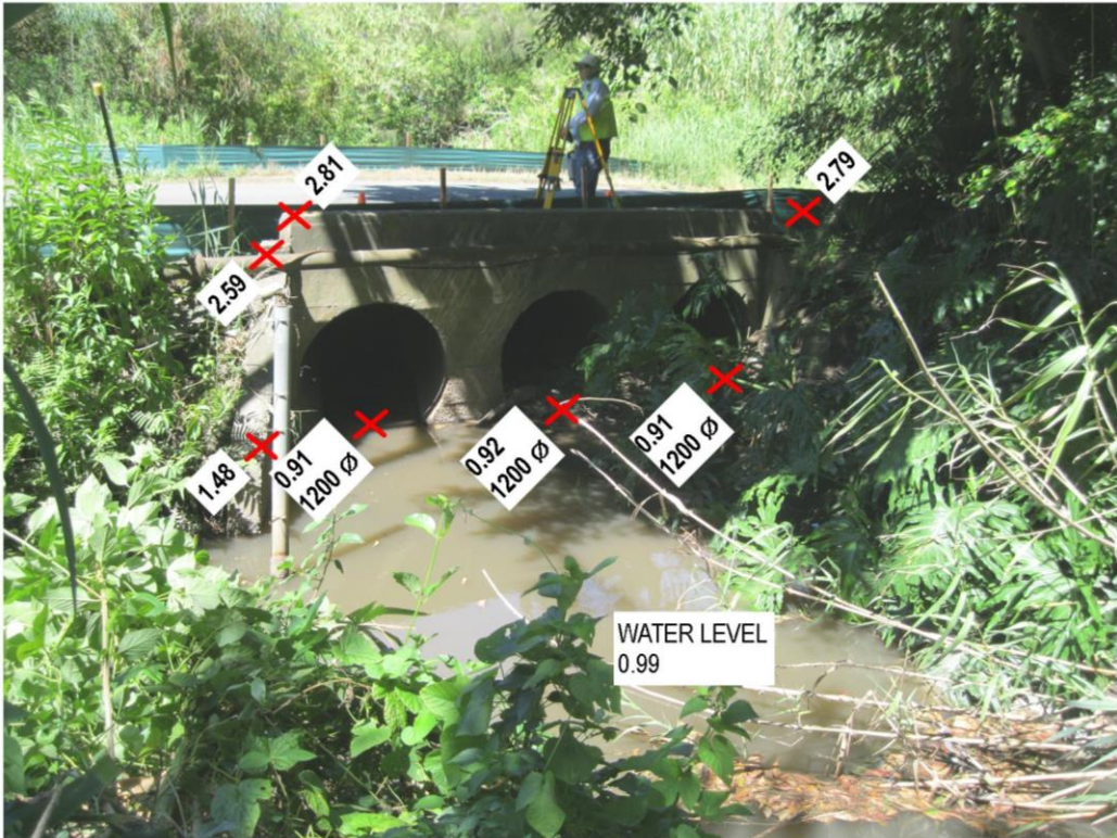
ID10-Culvert Nth ds
