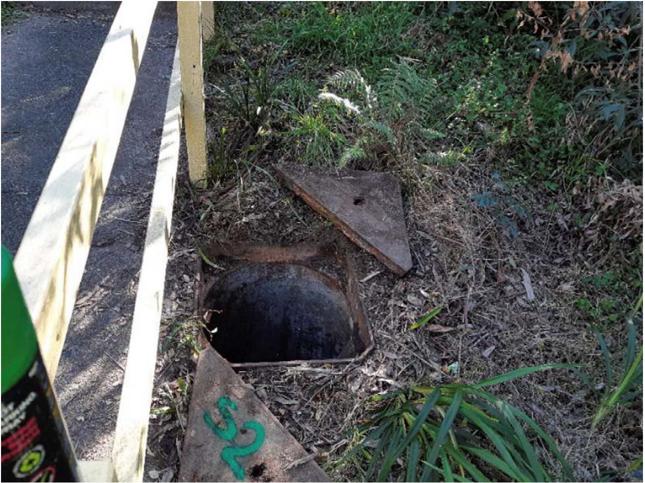
Sewer manhole s2
