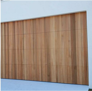
TIMBER BATTEN GARAGE DOOR
