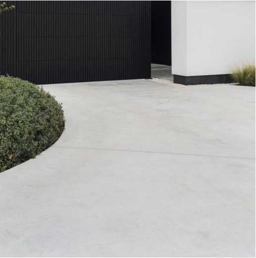
Code: CP-01 Material: Concrete Pour (Driveway)
