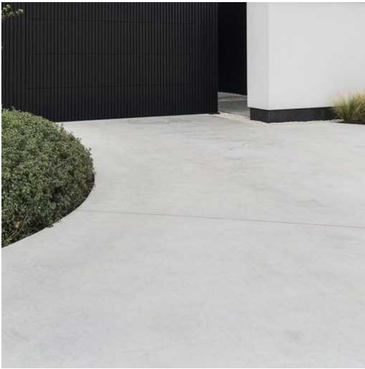
Code: CP-01 Material: Concrete Pour (Driveway)
